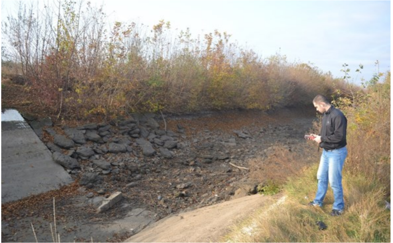
Рисунок 3.10 – Текущее техническое состояние Азовского магистрального канала
