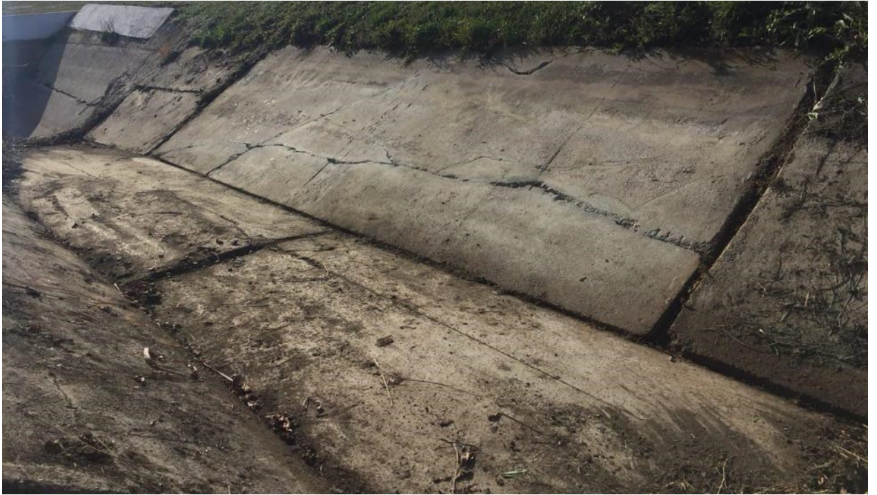
Рисунок 3.22 – Подготовленный участок мелиоративного канала для ремонта бетонной облицовки полимерными композициями
