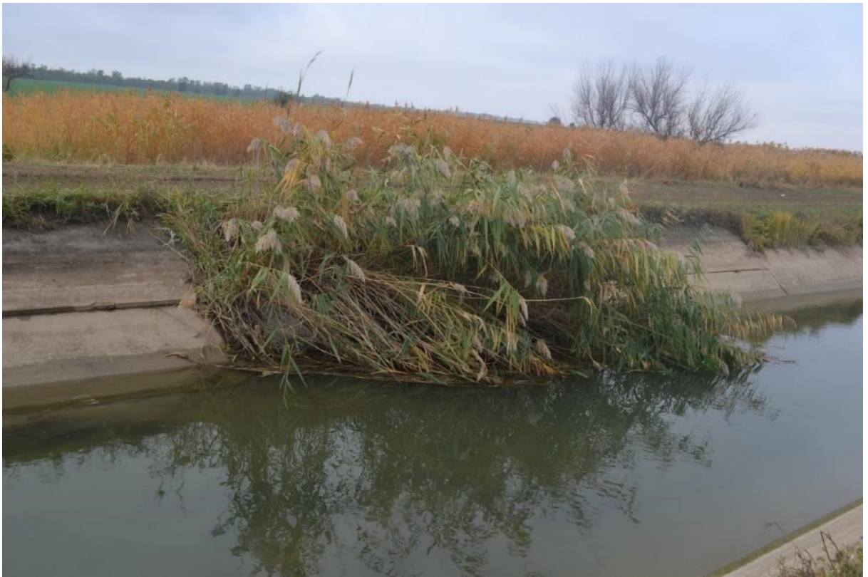
Рисунок 3.17 – Заращение откоса канала камышом
