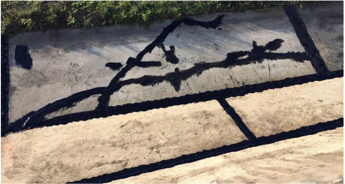
Рисунок 3.25 – Бетонная поверхность облицовки канала после ремонта композиционным материалом типа жидкая резина
