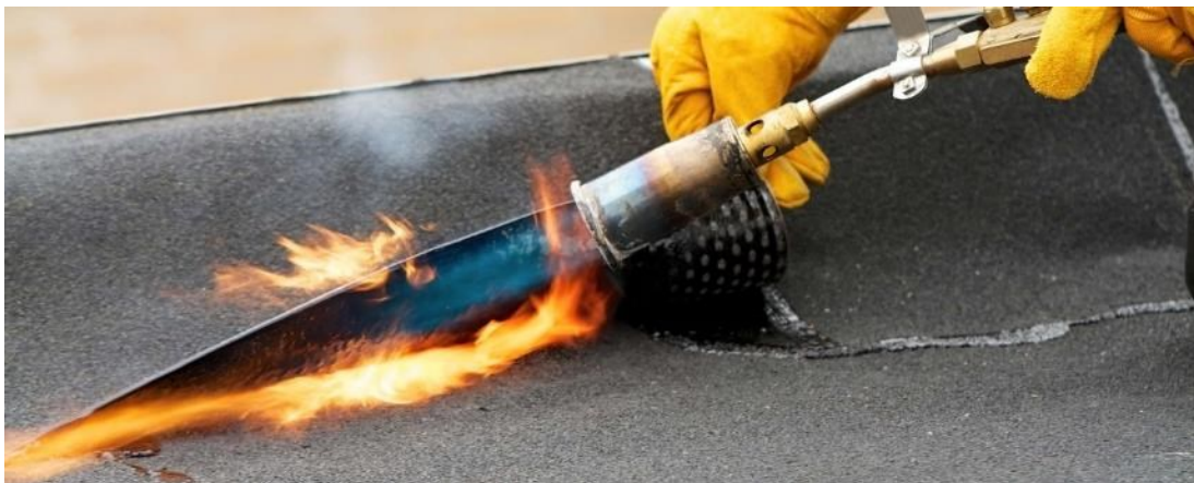
Рисунок 4.5 – Сварка нахлестных швов при помощи газовой горелки
