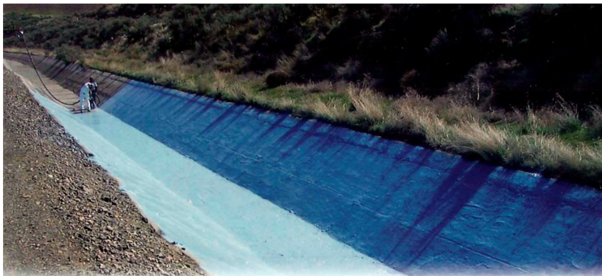
Рисунок 1.12 – Реконструируемый ирригационный канал в районе города «Kennewick», штата Вашингтон, США
