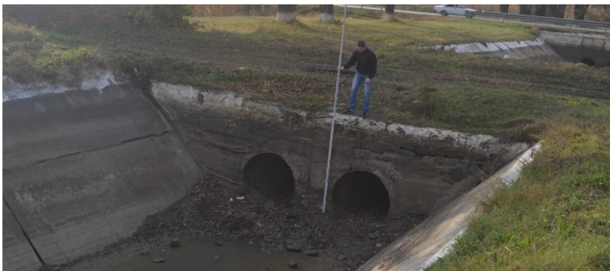
Рисунок 3.14 – Определение толщины донных отложений в распределительном канале Бг-Р-5
