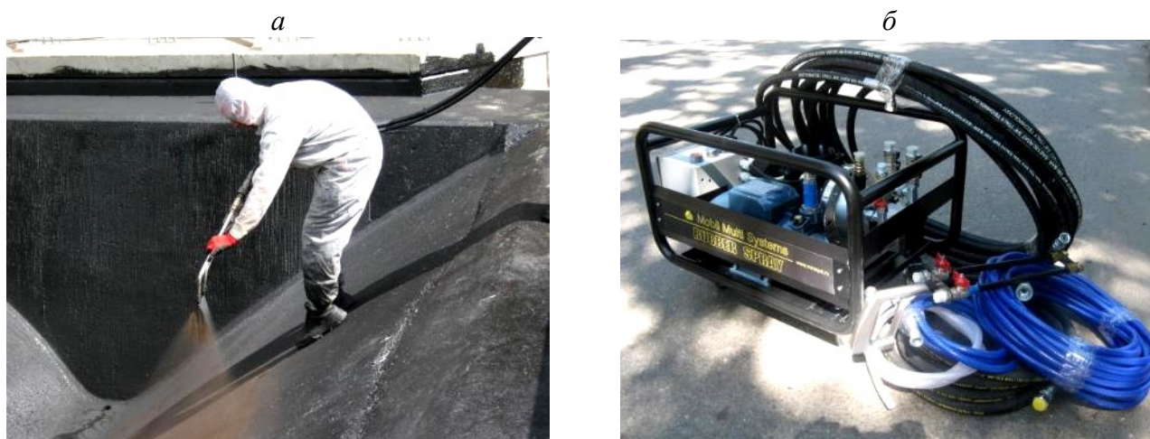
а – напыление жидкой резины на оросительном канале; б – отечественное оборудование для нанесения жидкой резины
