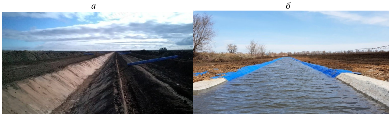
а – подготовительные работы; б – уложенный противofильтрационный элемент
