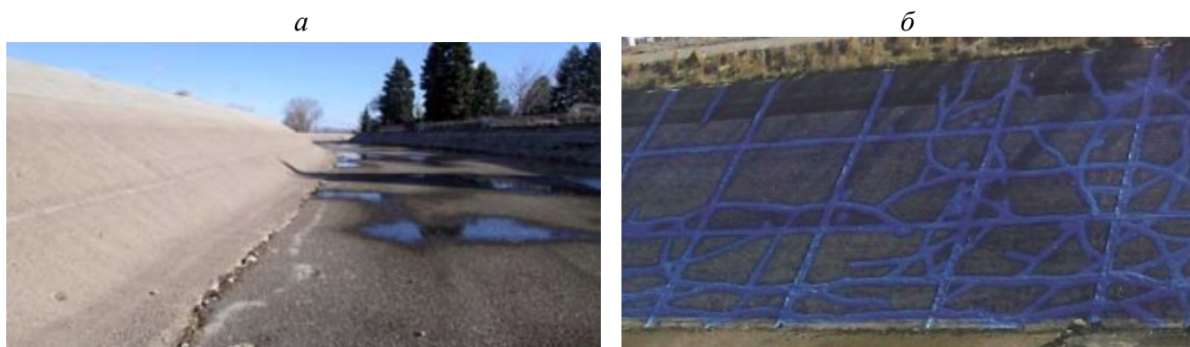
а – протяженный участок до ремонта; б – отремонтированный участок облицовки канала
