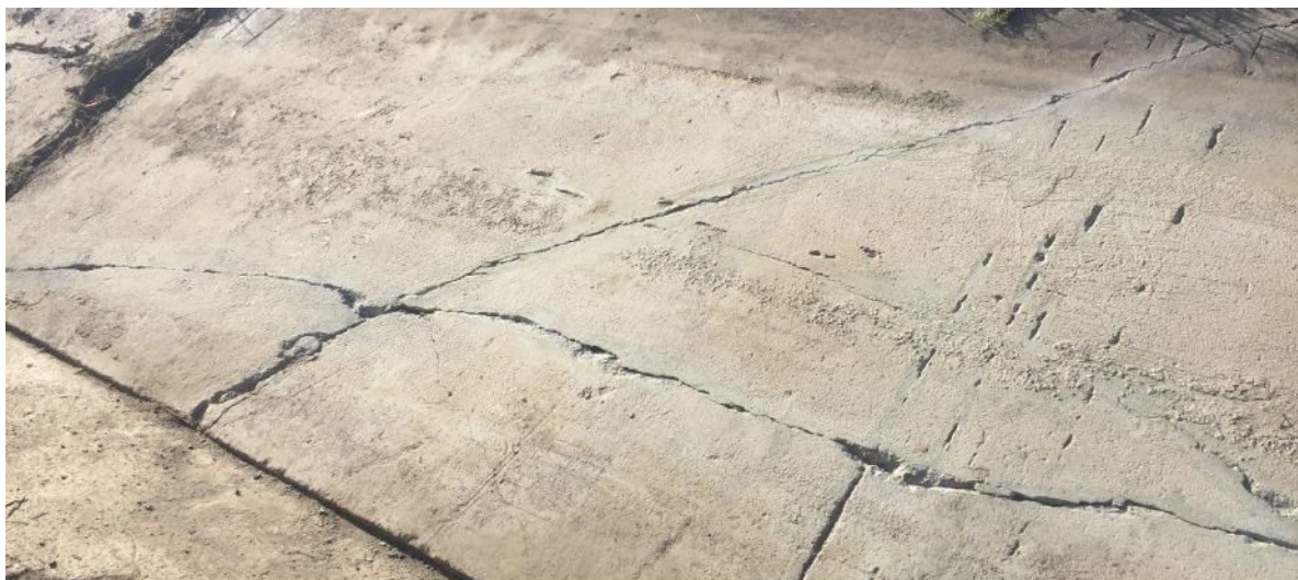
Рисунок 3.24 – Подготовленная бетонная поверхность облицовки канала для проведения ремонтно-восстановительных работ
