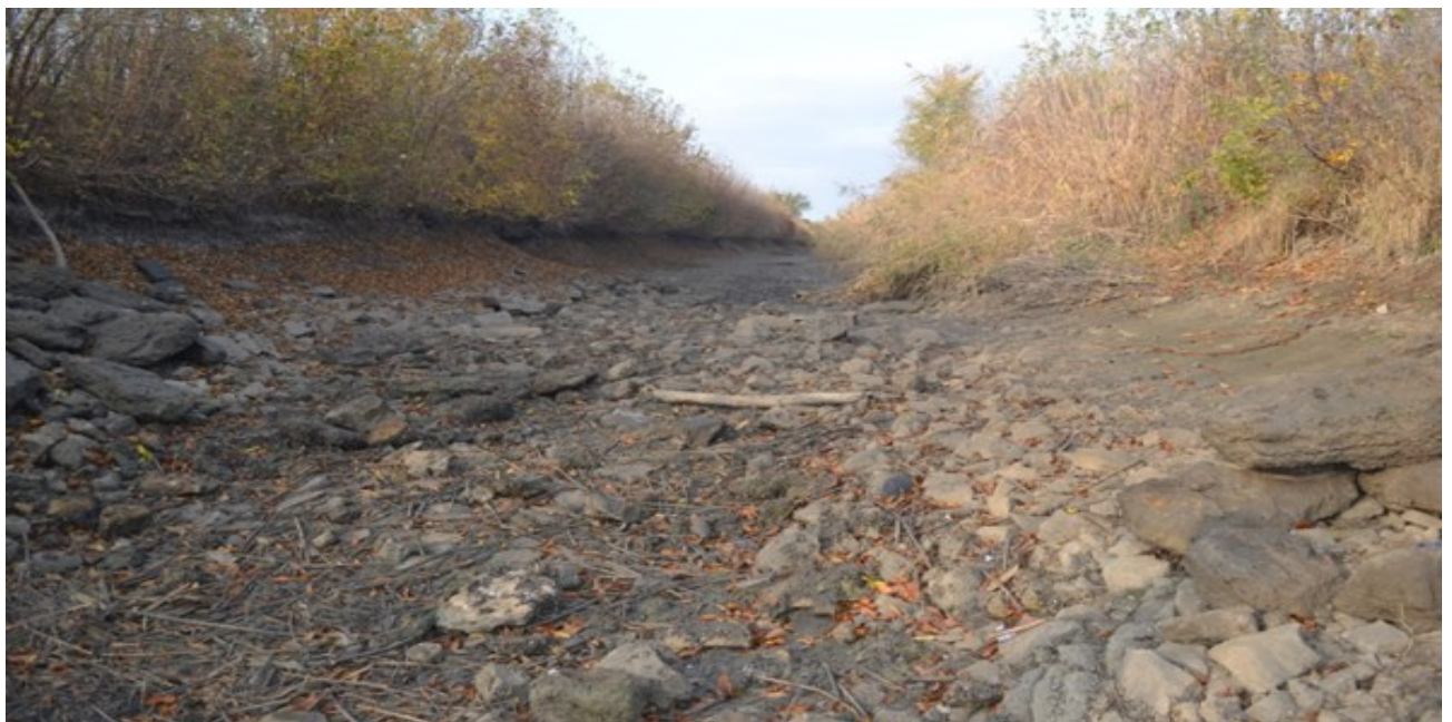
Рисунок 3.11 – Вид Азовского магистрального канала по дну (размыв русла и зарастание откосов канала камышом)
